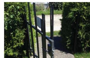
Fixation recto-verso pour assurer la cohérence esthétique. Système de rivetage à l'intérieur du profilé permettant l'inclinaison de la structure pour des reliefs de sols.
